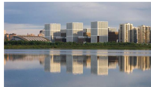
г. Казань, ЖК «SAVIN house»
